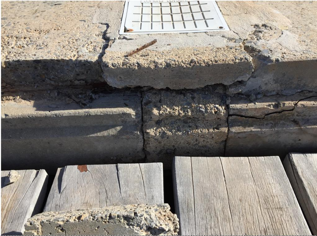
**FOTO 5 – BORDE PANTALAN-EMBARCADERO EN VIGA APOYO PLACAS ALVEOLARES**
