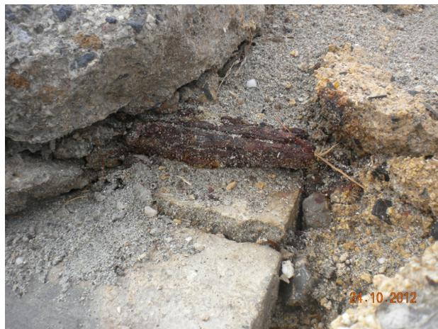
**FOTO 7 – CAPA COMPRESION PANTALAN PRESENCIA CORROSIÓN AVANZADA**
