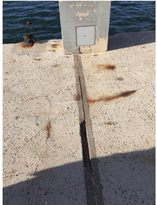
**FOTOS 4 – JUNTAS DILATACIÓN CAPA COMPRESIÓN PANTALAN**
