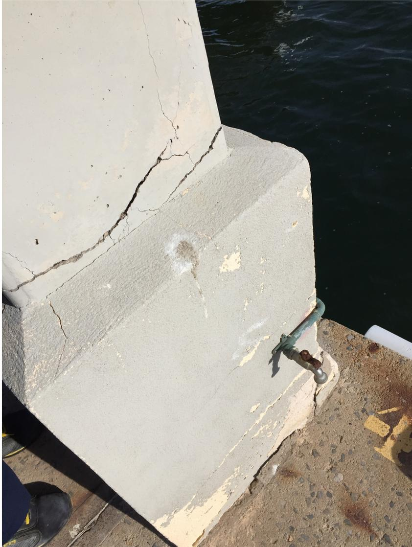
**FOTO 17 – VISTA DETERIORO ARMARIO SERVICIOS EXISTENTE**
