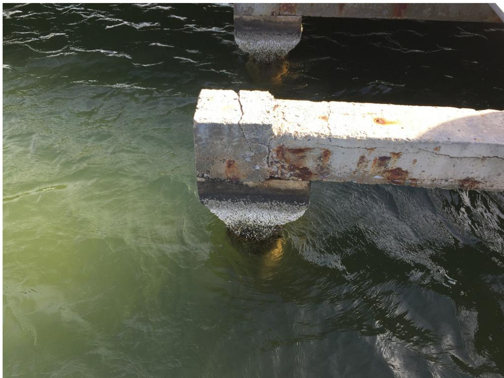
FOTO 13 – ESTADO DETERIORO VIGA EMBARCADERO
