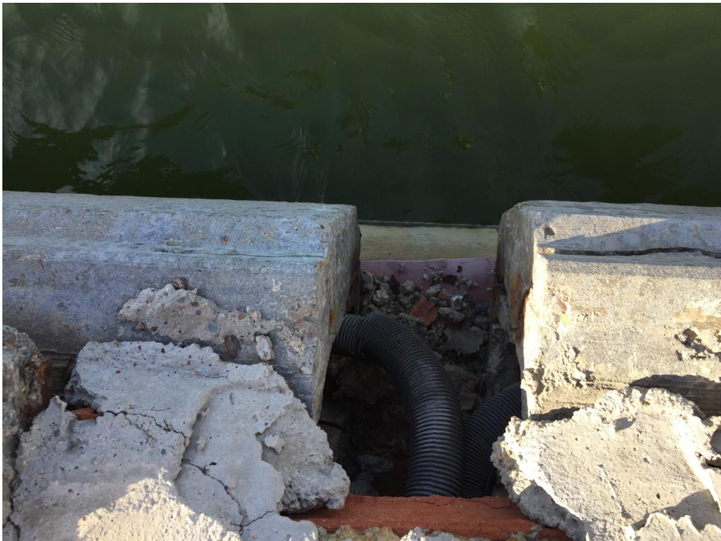
**FOTO 6 – BORDE PANTALAN EN VIGA APOYO PLACAS CON CANALIZACIONES VISTAS**
